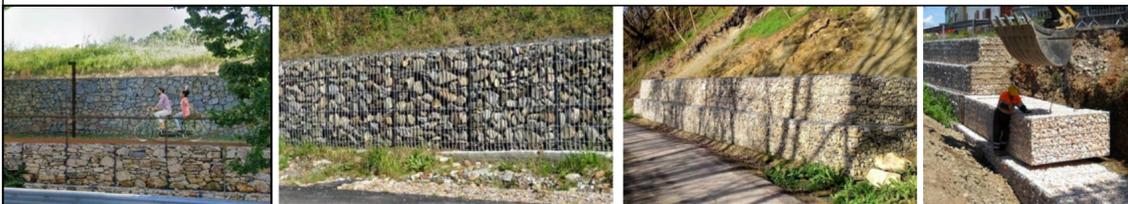
ESEMPI DI REALIZZAZIONI DI MURI DI CONTENIMENTO CON GABBIONI: Permeabilità, Reversibilità e bassissimo Impatto Ambientale
