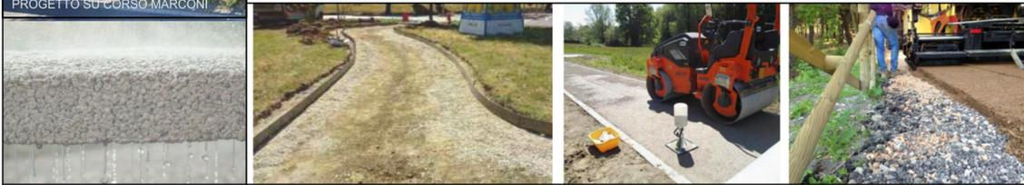
ESEMPI DI PAVIMENTAZIONI IN CLS DRENANTE O TERRA STABILIZZATA: Permeabilità, Ecocompatibilità dei leganti, totale Riciclabilità dei materiali, assenza di Resine e Materie Plastiche
